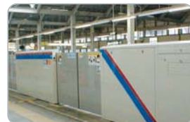
난간형 차량의 문위치에 맞춰 기둥문을 설치한 난간형태.
