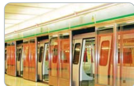
완전밀폐형 승강장과 선로부를 스크린도어로 완전히 차단하는 구조. (스크린도어 상부 인터리어 마감)
