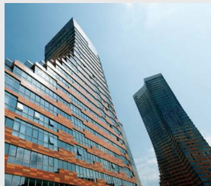
바리안 메리디안 호텔(58 Fl.) / 이스탄불, 터키 Speed : 240m/min(7units), 210m/min(5units) Total : 53units
