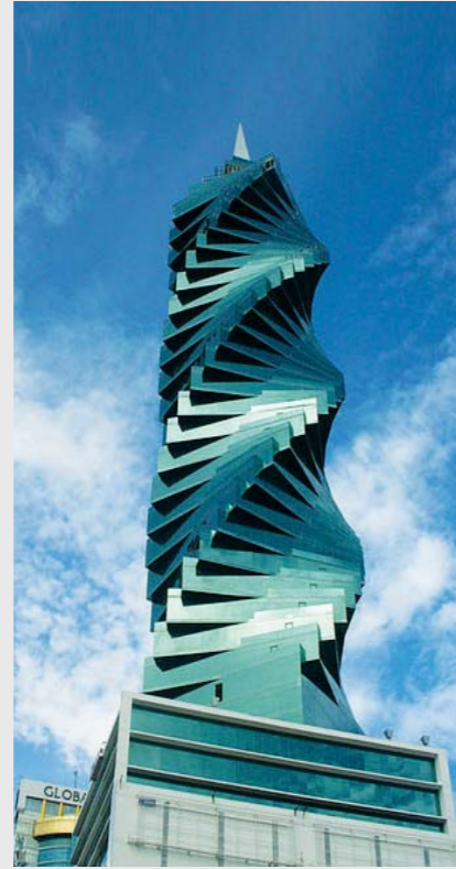
파나마 F&F 타워(55 Fl.) / 파나마시티, 파나마 Speed : 240m/min(5units) Total : 5units
