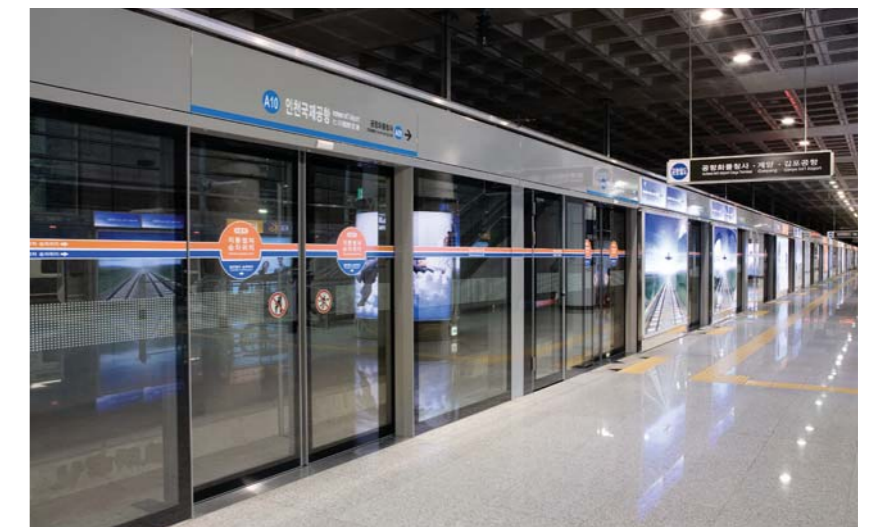
2008년에 인천국제공항과 서울역을 잇는 인천국제공항철도 전 구간의 10개 역 26개 승강장에 스크린도어를 설치했다.
