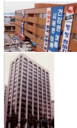
인천 희망백화점 현대무교빌딩
