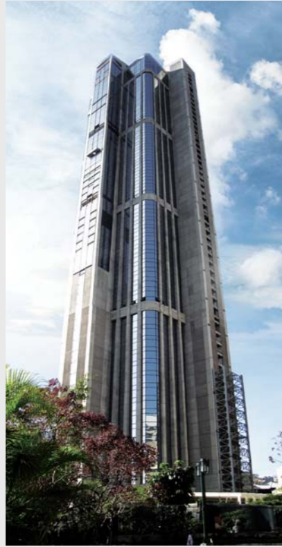
베네수엘라 정부종합청사 / 카라카스, 베네수엘라 Speed : 480m/min (2units), 420m/min (5units), 360m/min (4units) Total : 22units
