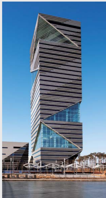
송도 G타워(33 Fl.) / 인천, 한국 Speed : 360m/min(2units) Total : 18units
