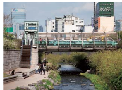
2009년 청계천 삼일교에 국내 최초로 설치된 '승강로 방수형 엘리베이터'
