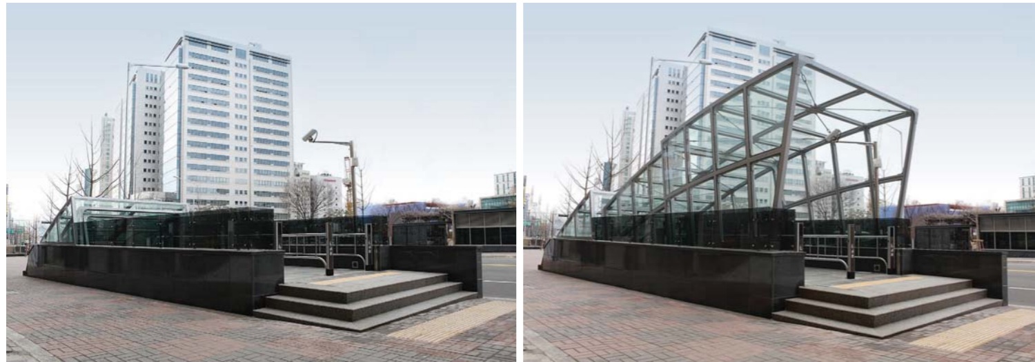
서울지하철 3호선 경찰병원역에 설치된 곡선형 자동접이식 캐노피
