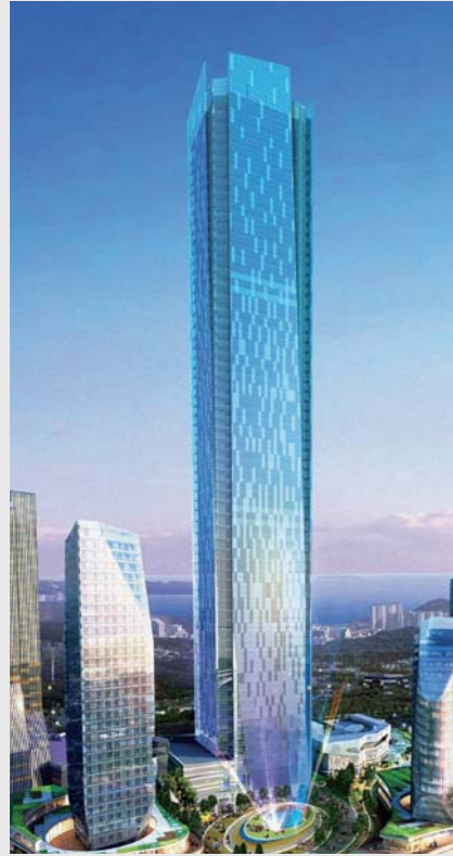
부산국제금융센터(BIFC) / 부산, 한국 Speed : 600m/min(2units), 540m/min(3units), 480m/min(8units) Total : 32units
