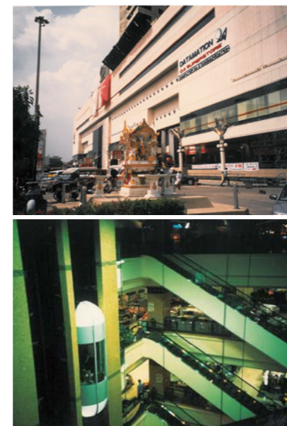
1994년 당시 최대 규모의 수주 성과를 올린 태국 임페리얼월드 백화점. 사진은 전경(위)과 내부 설치물(아래)
