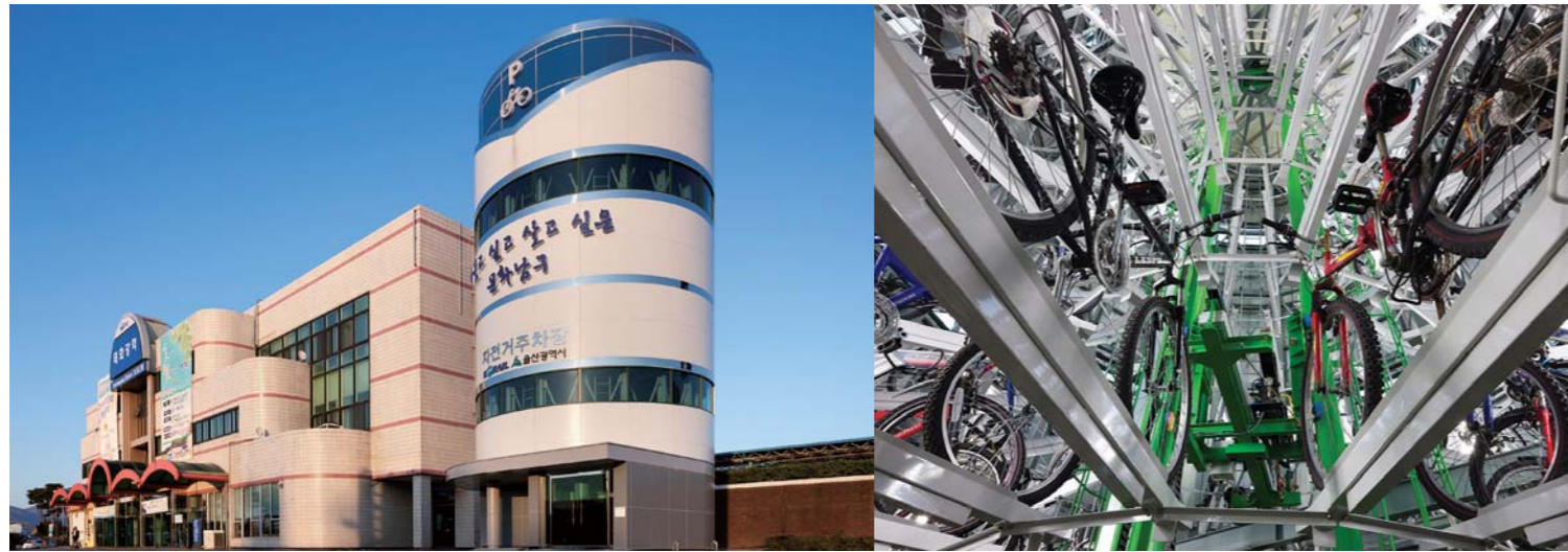
2010년 12월 울산 태화강역에 설치한 자전거 주차장은 승강회전식 모델로, 좁은 공간에도 불구하고 168대를 주차할 수 있다.
