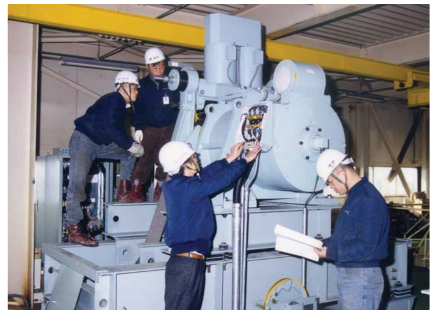
AC Gearless 300m/min 권상기
